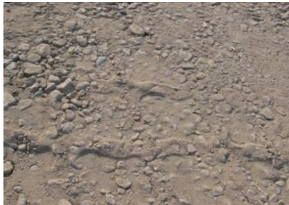
gut verdichteter Unterbau
